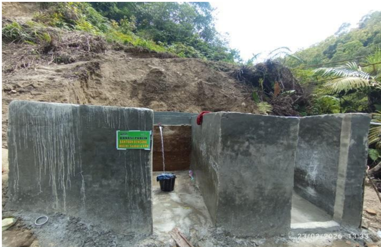
Pembangunan tandon penampungan air di Desa Sitapongan, Kecamatan Sijamapolang, Kabupaten Humbang Hasundutan.
