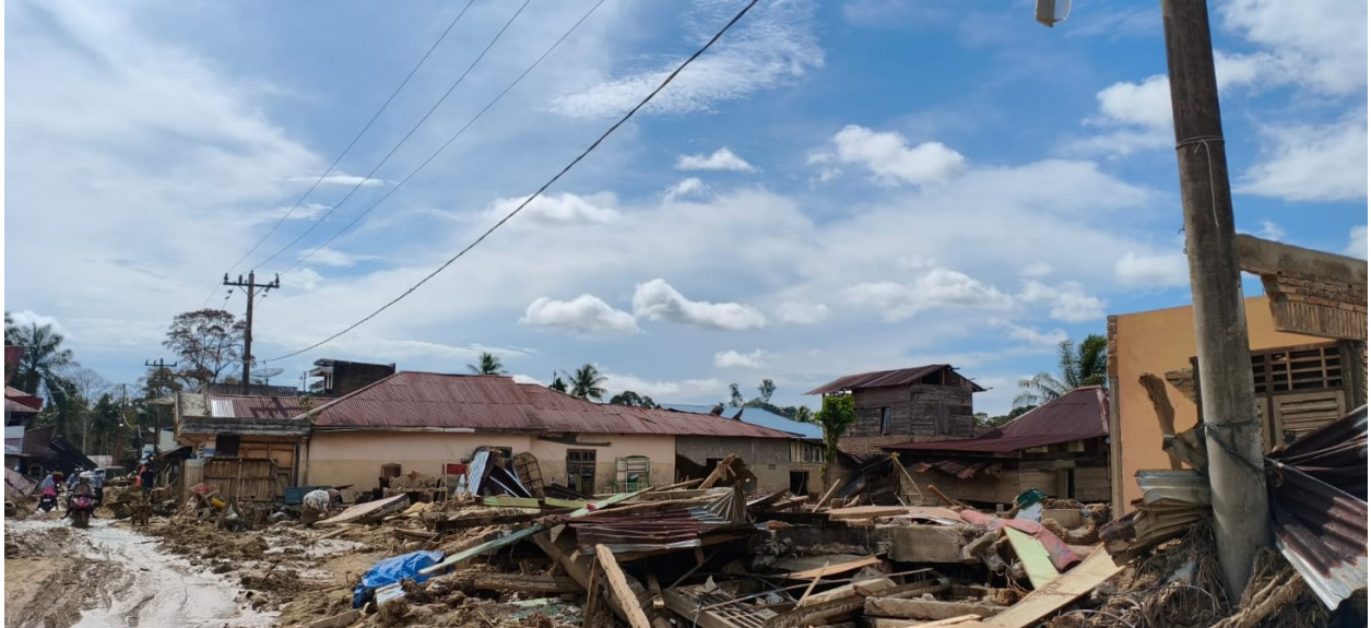
Kerusakan rumah dan infrastruktur warga akibat banjir bandang dan tanah longsor di Tapanuli Tengah | Foto: WALHI Sumut
